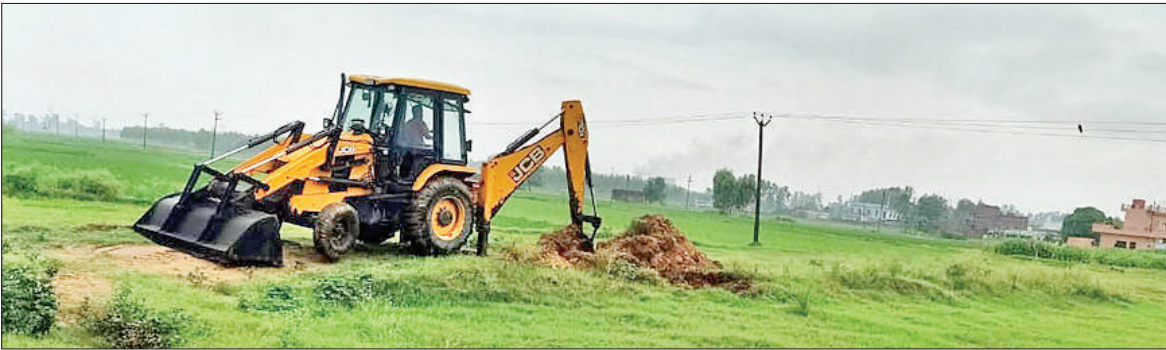
यमुनानगर। साढ़ौरा सरावन रोड पर अनाधिकृत कॉलोनी में अवैध निर्माण को ध्वस्त करते हुए जेसीबी मशीन।
